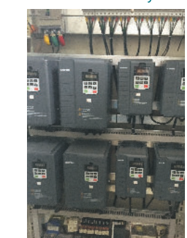
水处理系统 Water treatment system
